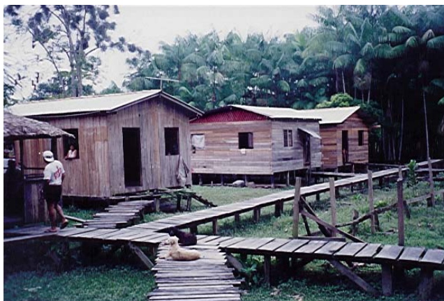
Figura 5 - Tipos de construções mais comuns do Setor Estuarino. Fonte: Acervo GERCO.
