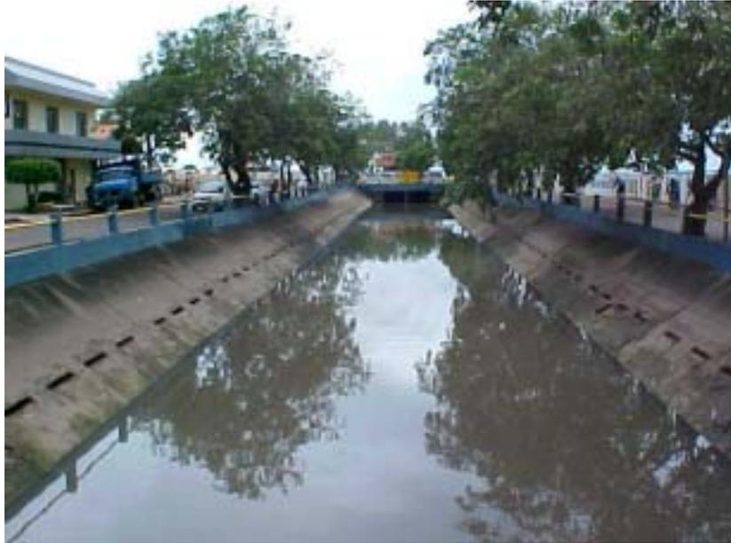
**Figura 27** - Canal de captação de águas pluviais (Macapá).
