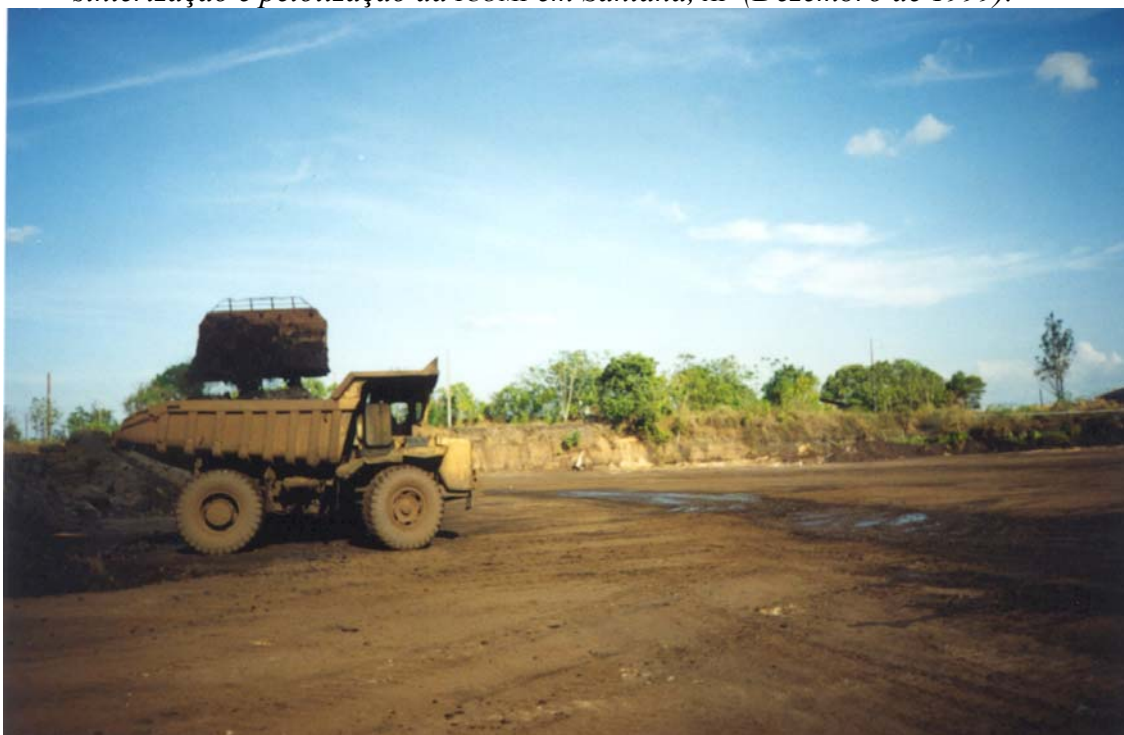
Figura 11: Retroescavadeira e caminhão realizando a remoção de material da bacia na qual se estocavam rejeitos provenientes do beneficiamento de minério de manganês nas usinas de sinterização e pelotização da ICOMI em Santana, AP (Dezembro de 1999).
