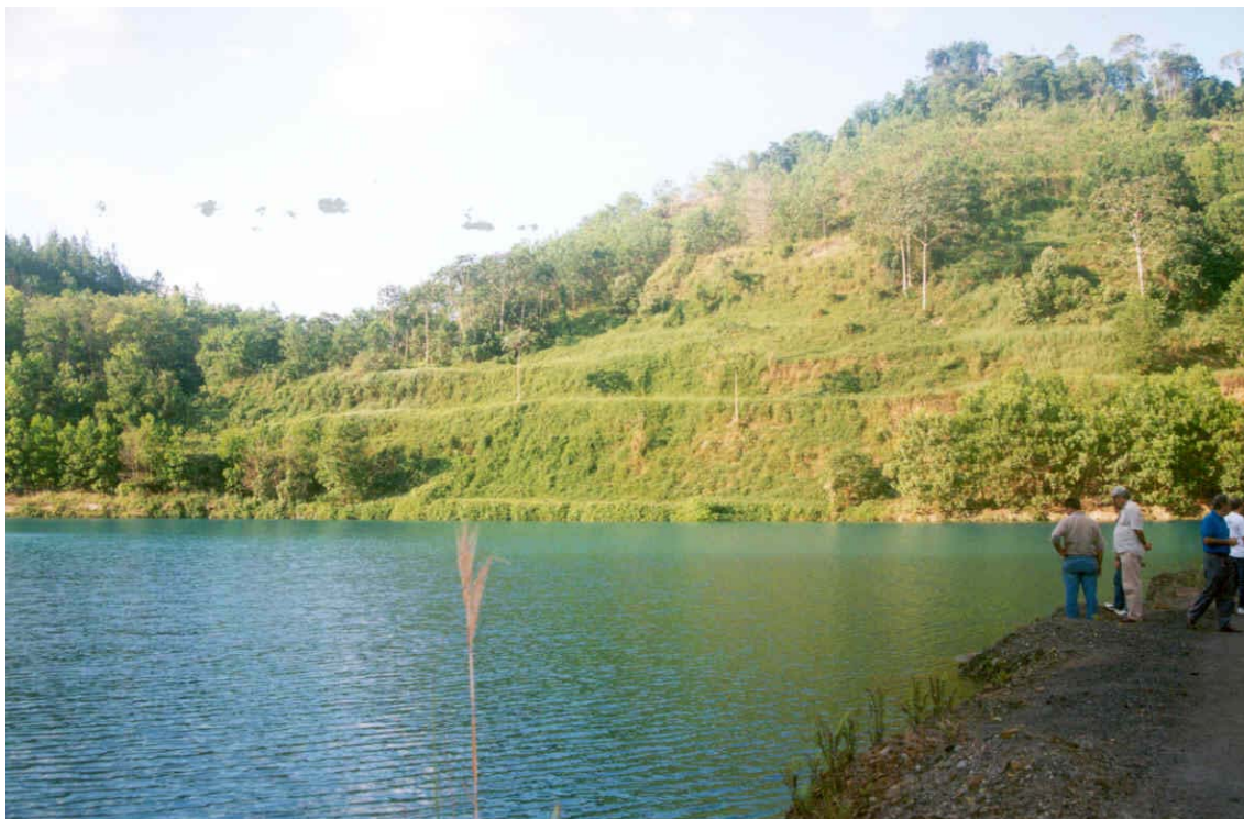
Figura 8: Cava aberta em decorrência da exploração do minério de manganês da mina Terezinha 6; do solo vegetal até a linha d'água criou-se um desnível de 70 metros. Abaixo desta linha, há mais 100 metros de desnível submersos, Serra do Navio, AP (Agosto de 2002).
