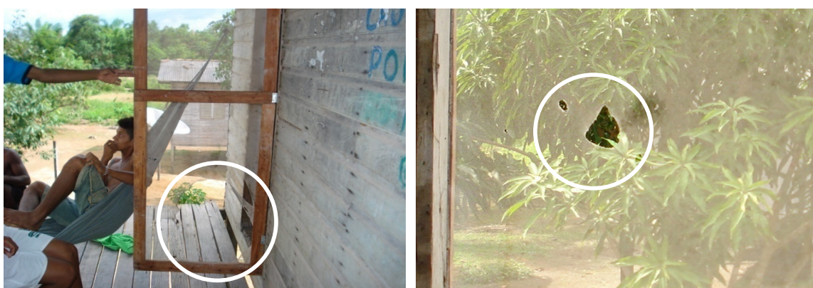
Figura 22. Telas apresentando danos provocados pelo tempo e uso por parte dos moradores
