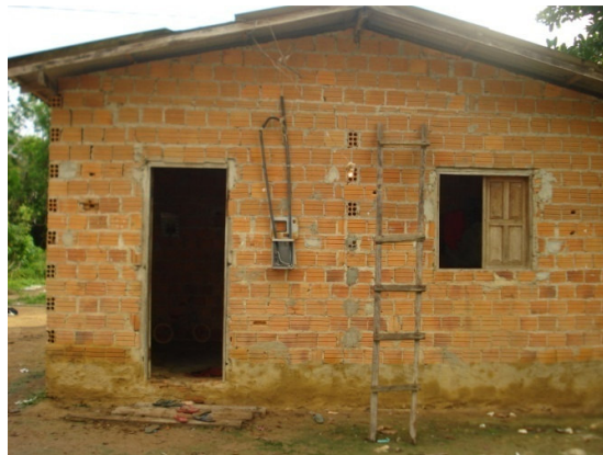
Figura 07. Casas de alvenaria sem reboco
